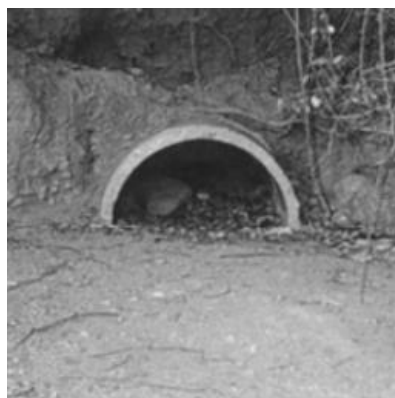
(d) 渠洞影像
